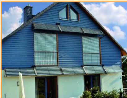
Angestellte Fassadenmontage von 8 TUBO-Modulen, Deutschland
